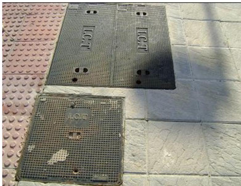
Ilustración 15. Arqueta de entrada a edificio con despliegue interior.
