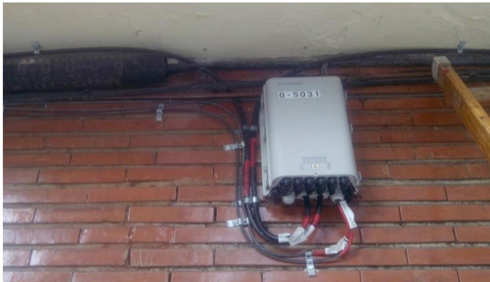
Ilustración 20. Detalle de la Caja terminal óptica (CTO) exterior.
