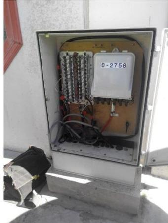
Ilustración 24. Caja terminal óptica (CTO) instalada en Pedestal.
