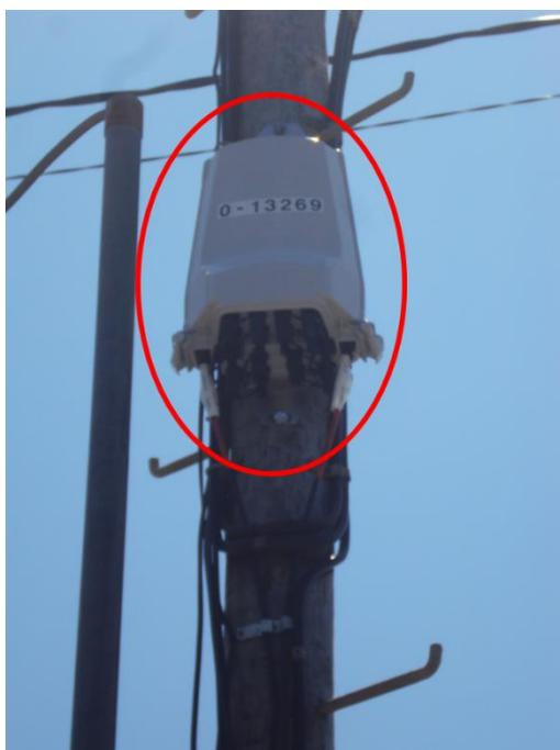
Ilustración 23. Caja terminal óptica (CTO) instalada en Poste.
